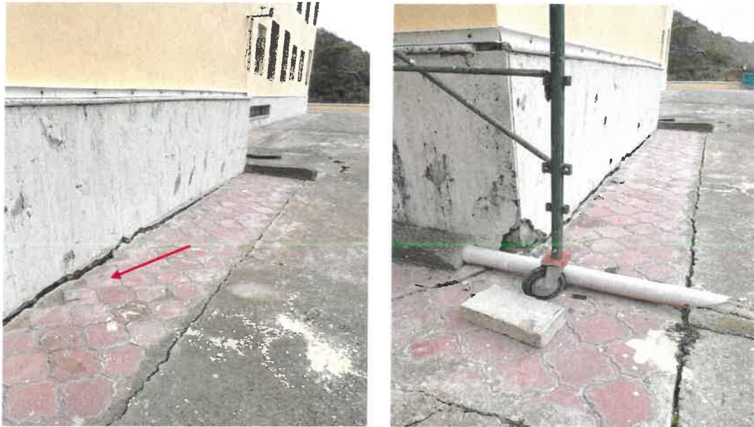
Fig.3 Pamje nga pjesa e shkeputur e trotuarit te pasem te objektit
