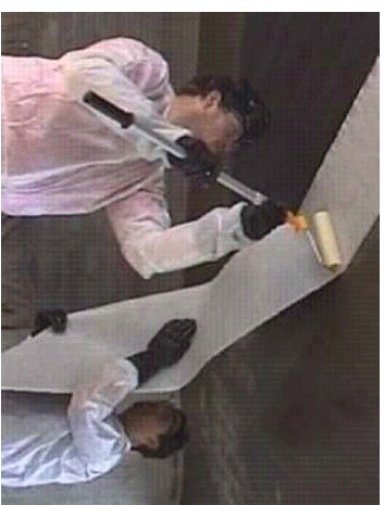
FAZA 3 - VENDOSJA E FIBRAVE TE KARBONIT, SIPAS SPECIFIKAVE TE PRODHUESIT
