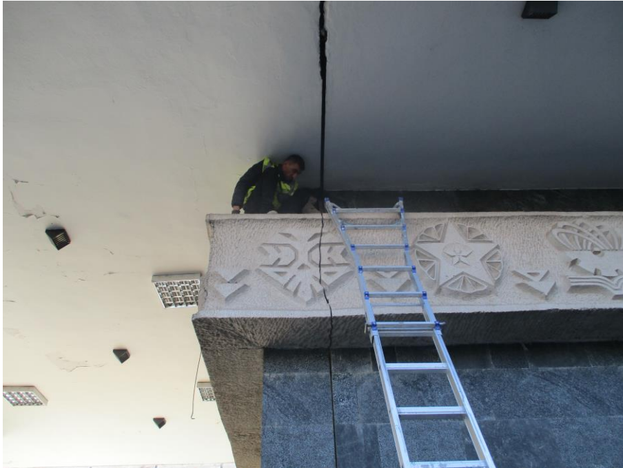
Fig 15. Pozicioni Nr.1, Kolona ne aksin N9, Kati 0, Floor 0, Prova pa shkatërrim me Sklerometer
