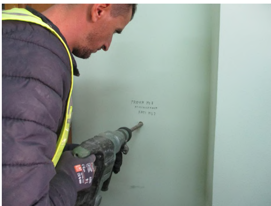
Fig 22. Pozicioni Nr 7, Mur tulle e plote ne aksin M15-N15
