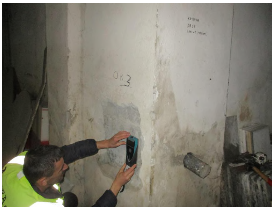
Fig 7. Pozicioni Nr.3, Skanimi i armatures se hekurit / Përcaktimi i Shtresës mbrojtëse të betonit
