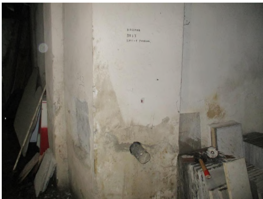
Fig 6. Pozicioni Nr.3, Marrja e mostrave te karrotave te betonit
