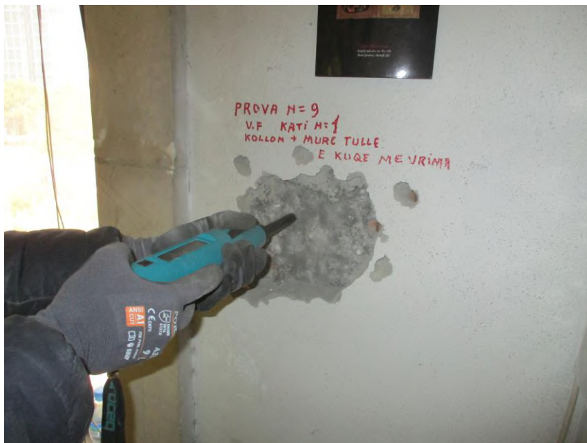
Fig 25. Position no 9, Prova pa shkaterrim me Sklerometer (kryer ne kollonat e betonit ne ane te dritares) Rezultatet e testit shprehen më poshtë në seksionin përkatës.
