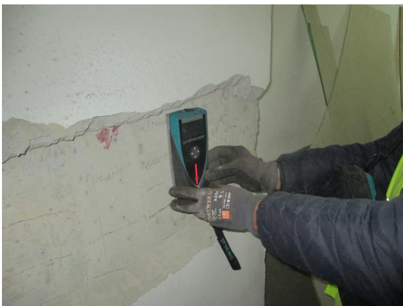
Fig 10. Pozicioni Nr.5, Skanimi i armatures së hekurit / Përcaktimi i Shtresës mbrojtëse të betonit
