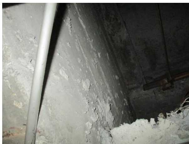
Fig 19. Pozicioni No.4, Trau në aksin C12, Kati 0, Prova pa shkaterrim me Sklerometer
