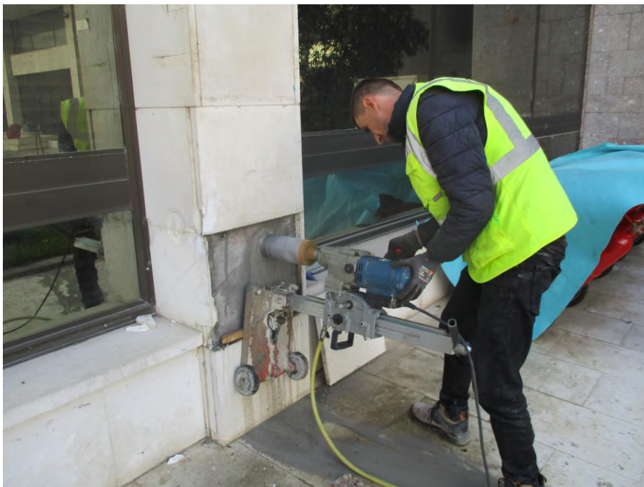
➤ Fig 16. Pozicioni Nr.2, Kolona ne aksin D9', Kati 0, Marrja e mostres se karrotes se betonit.
