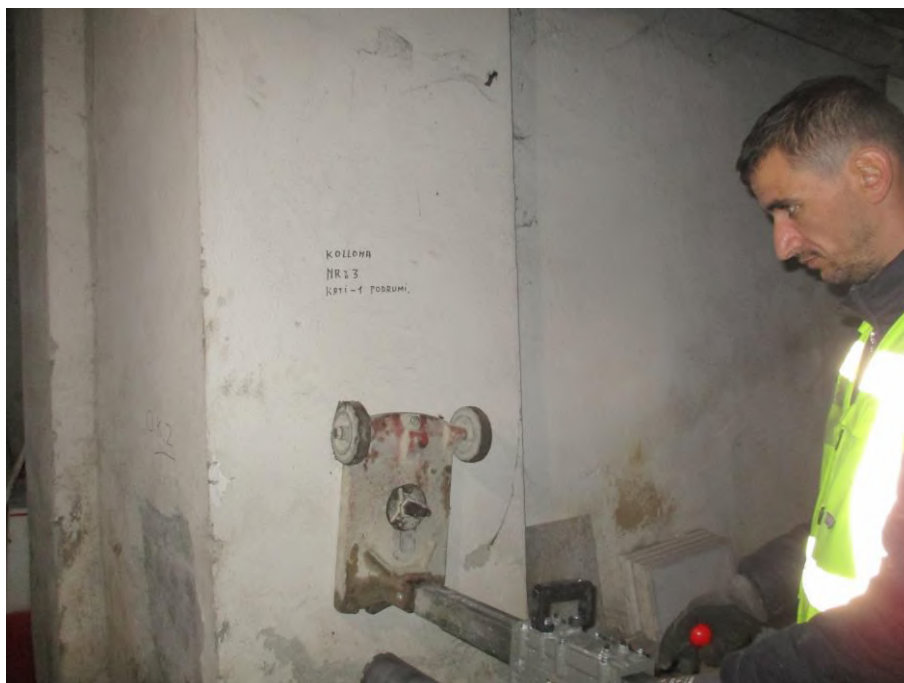
Fig 5. Pozicioni Nr 3, Marrja e mostrave te karrotave te betonit
