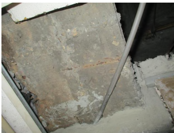
Fig 19. Pozicioni No.4, Trau në aksin C12, Kati 0, Prova pa shkaterrim me Sklerometer
