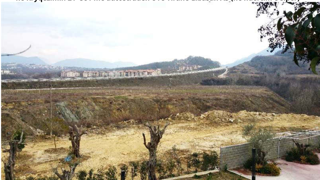
Figura 7. Zona e pikës fundore "F" të Bypass-it të Tiranës në kryqëzimin e ri (forma e borisë) në Kryqëzimin 21+581 me autostradën e re Tiranë-Elbasan A3 (në ndërtim e sipër)
