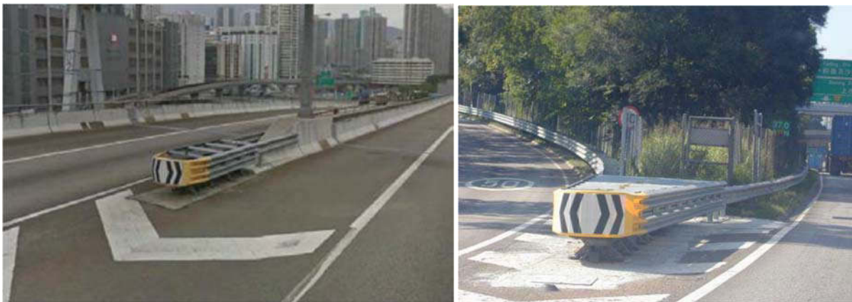
Figura 7-5 Llojet e jastëkëve shtypës të përdorur për gore të ngushta (majtas) dhe të gjera (djathtas) divergjente
