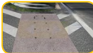
Baza e betonit të parafabrikuar
