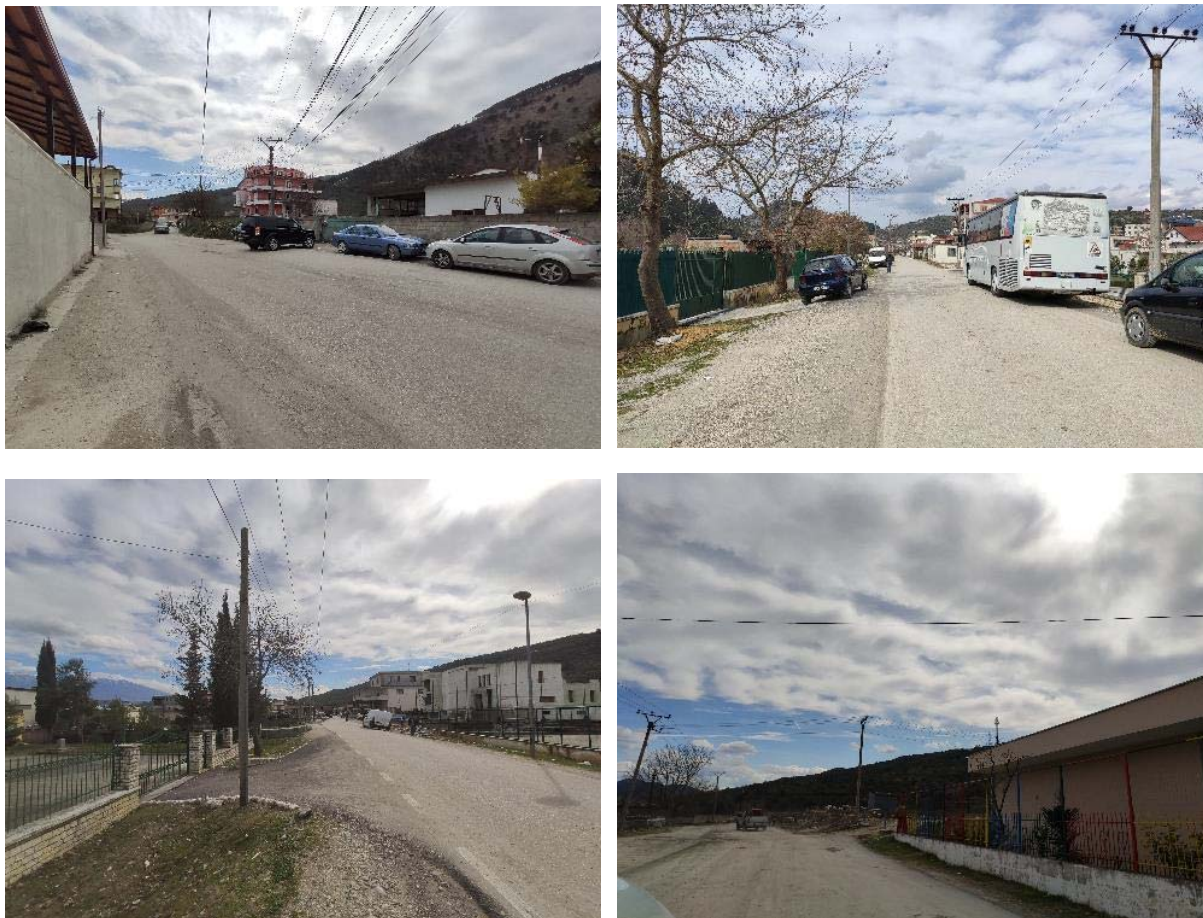
Figura 5 –Foto te gjurmes ekzistuese-Rruga mbi argjinature
