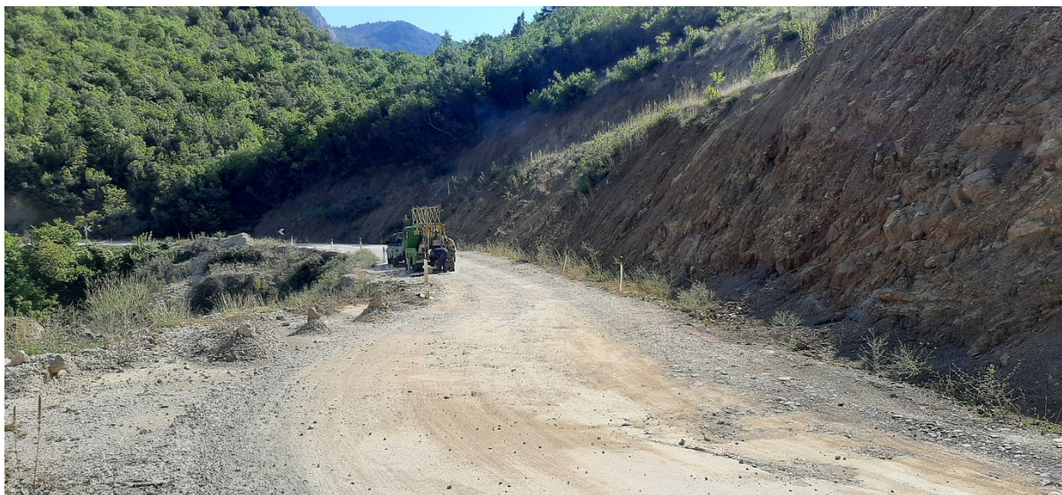
Foto Nr.10 Rruga ne km 24+060, ka pesuar ulje te bazamentit dhe konsumi total i asfaltit
