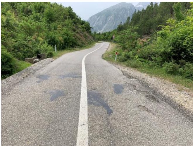
Foto Nr.10 , Km.11+000
