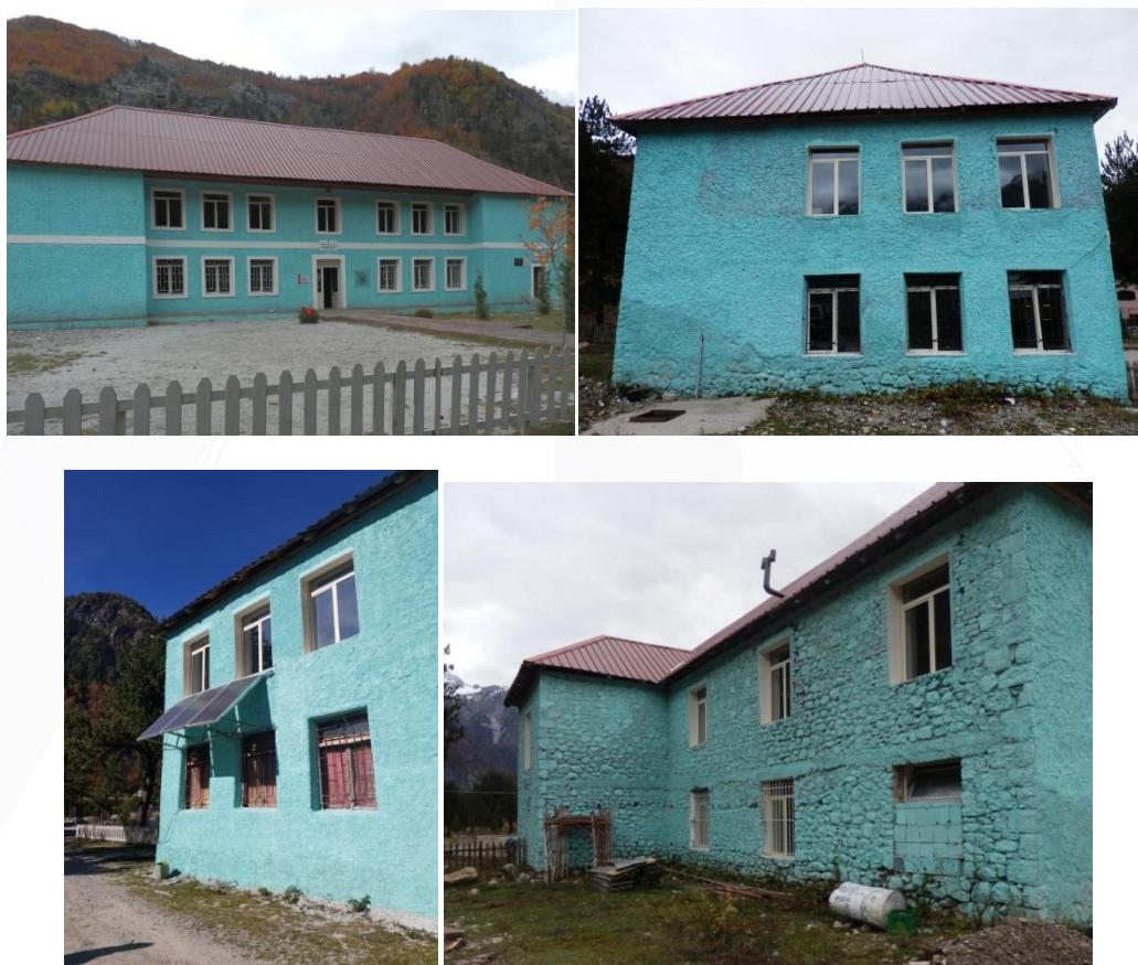
Figura 28 Foto ekzistuese të objektit të shkollës.
