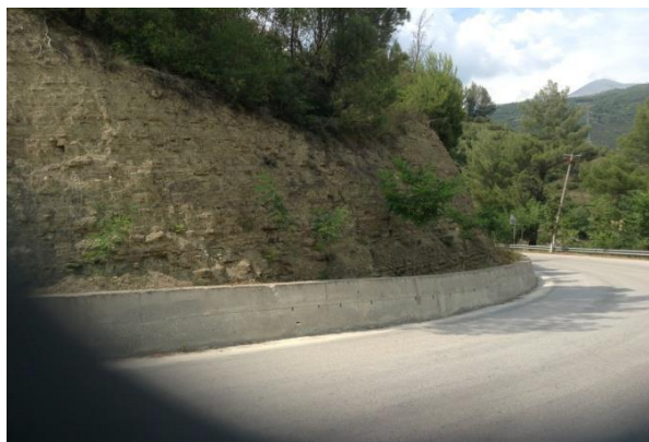
Figure 11 – Flishi dhe elementet e renies se tij ne rrugen nacionale
