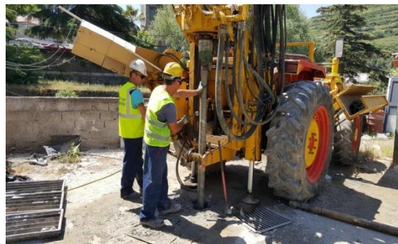
Figura 5 - Sonda Nr.2 në shpatullën e djathte të strukturës
