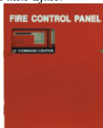
Figura 24 : Central alarmi zjarrit, digjital, tip inteligjent i adresueshem sipas EN54
