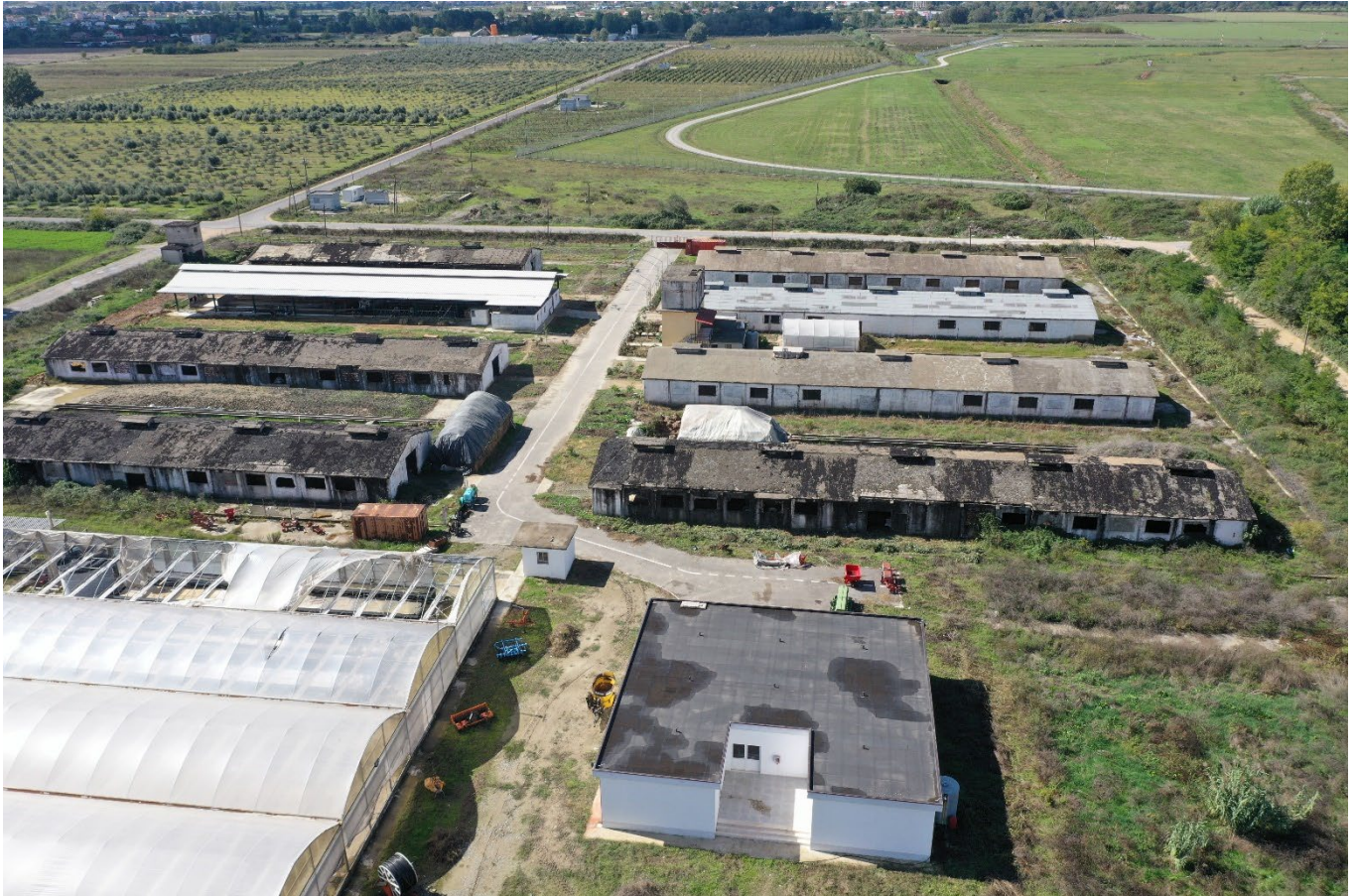
Figura 4-1 Foto e gjendjes ekzistuese te godinave
