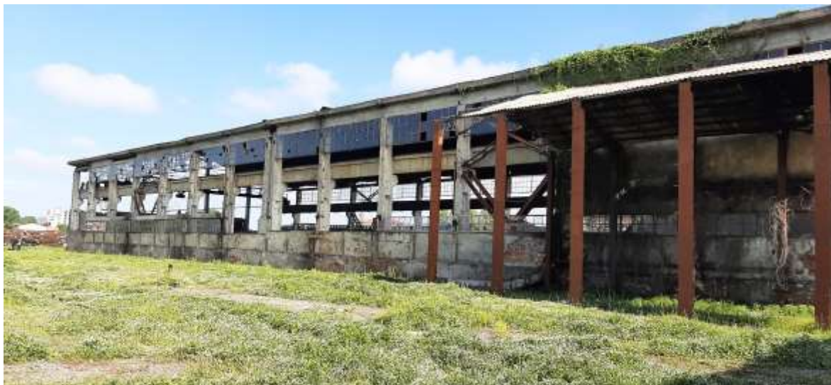
Fig. Reparti i riparimit te lokomotivave
