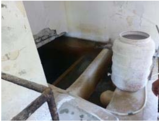
Kuçova Devolli zona e puseve- Dizinfektimi manual
