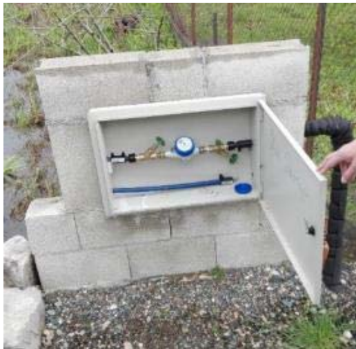
Figure 34: Lidhje shtëpie, e instaluar së fundmi
