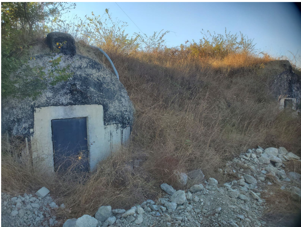
Foto te vend-streimeve ne afersi te zones ku do te ndertohet Depo Agonas (Kanaparaj)
