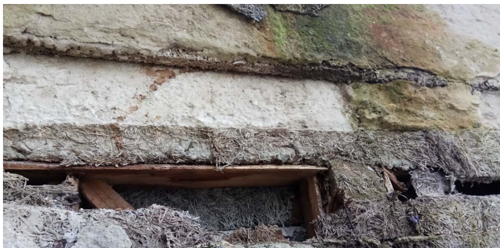
Fig.3 Struktura horizontale që lidh kolonat
