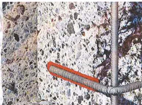
DETAJ I RIPARIMEVE TE MUREVE TE DENTUARA
