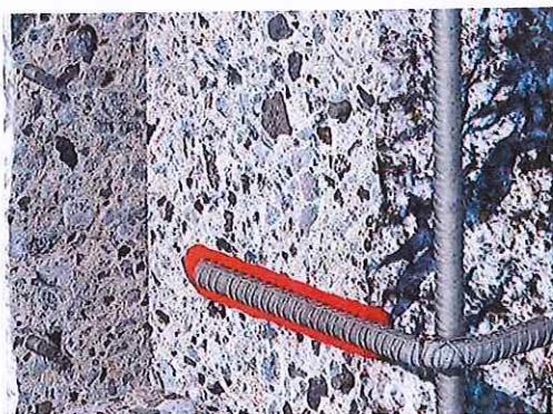
DETAJ I RIPARIMEVE TE MUREVE TE DENTUARA
