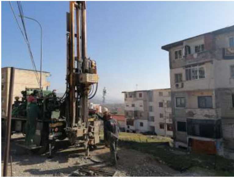
Foto nr.1 Pozicioni i sondes ne BH-1
