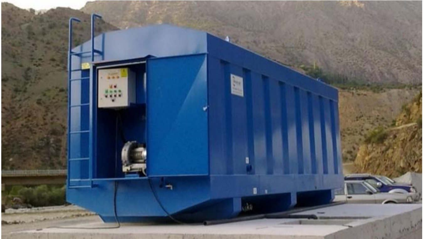
Pamja e nje njesie SBR e parapergatitur konstrukcion çelik
