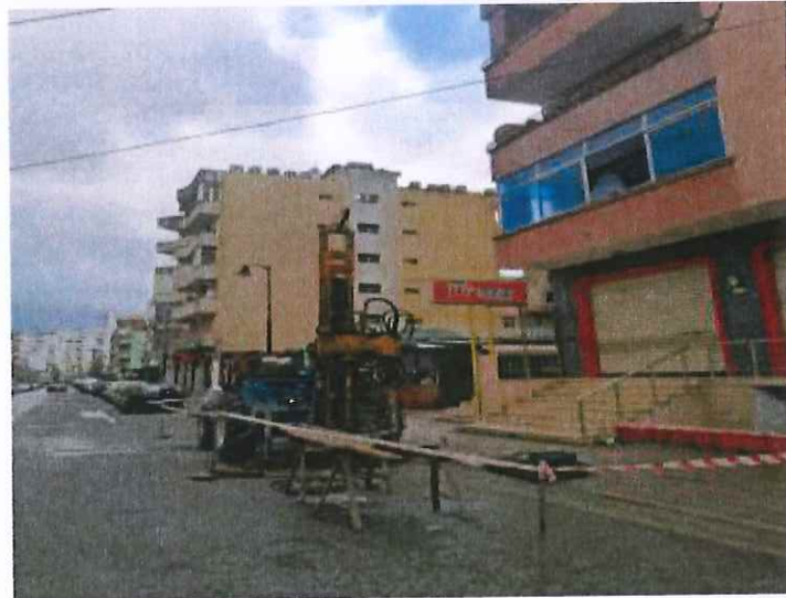
Foto nr.1 Pozicioni i sondes ne BH-1
