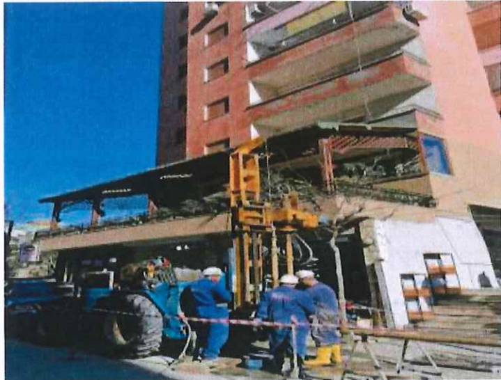
Foto nr.11 Pozicioni i sondes ne BH-3
