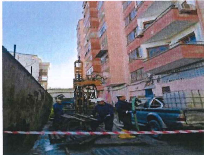
Foto nr 6 Pozicioni i sondes ne BH-2
