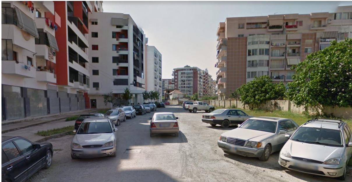
Foto te Gjendjes Ekzistuese Rruga "Rexhep Shala"
