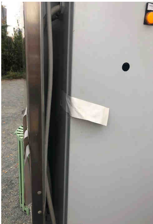
Demtime te paneleve gjate kohes
