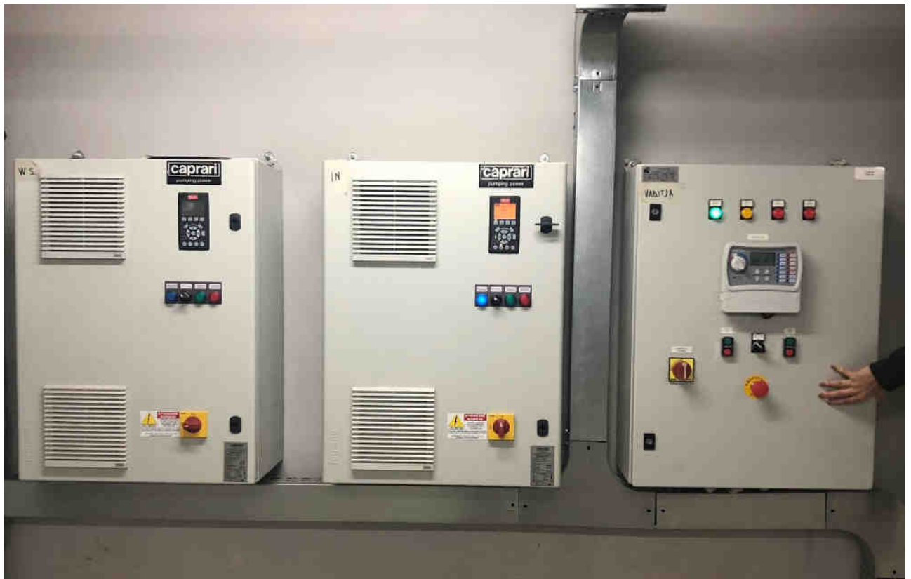
Panet elektrike te shatervaneve me ekran uji, te shatervanit inteligjent te vaditjes
