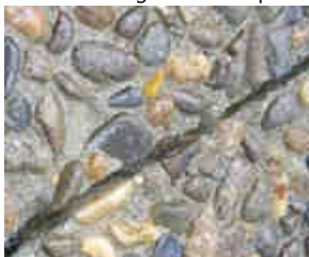
Fugat ne siperfaqet me beton
