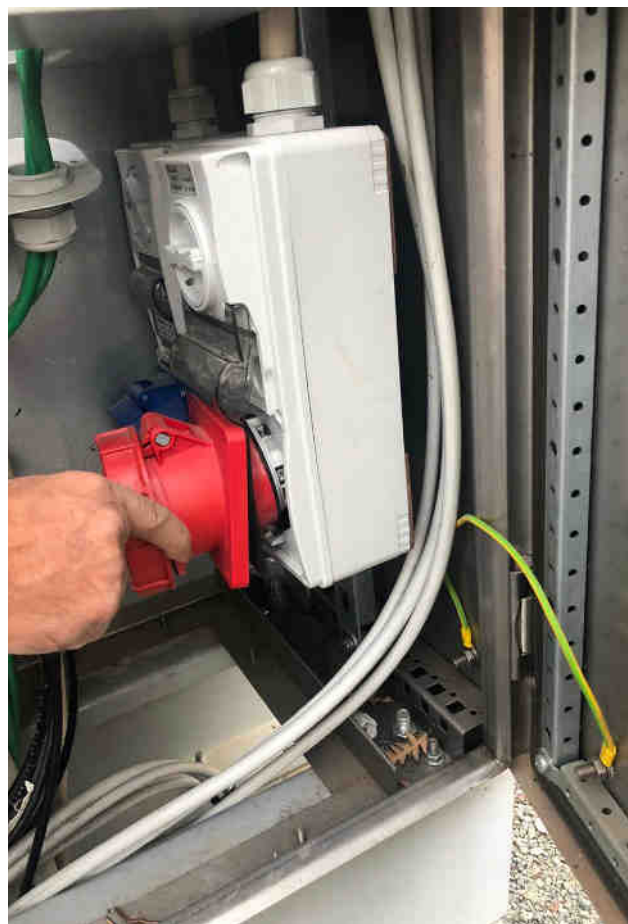
Demtime te paneleve gjate kohes
