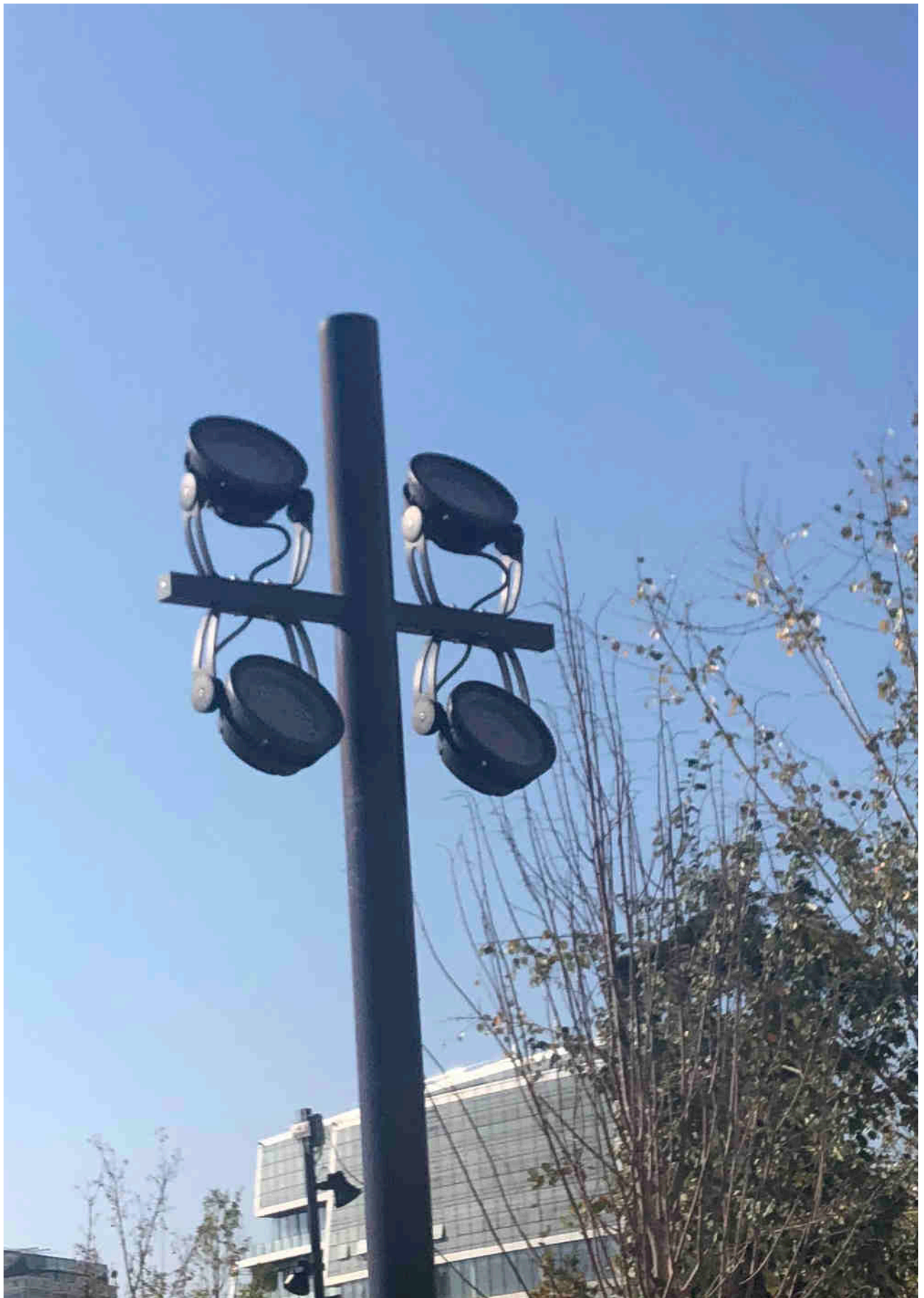
Ndricuesi i tipit prozhektor, i perdorur per theksimin e detajeve arkitektonike ne te gjitha fasadat rreth Sheshit Skenderbej
