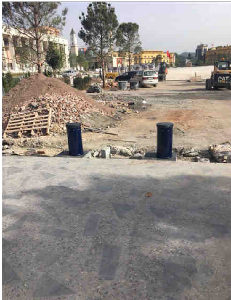
Pistonat qe bllokohen hyrjen e automjeteve ne shesh
