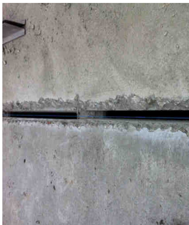
Foto e kanalit Gatik gjate procesit te ndertimit
