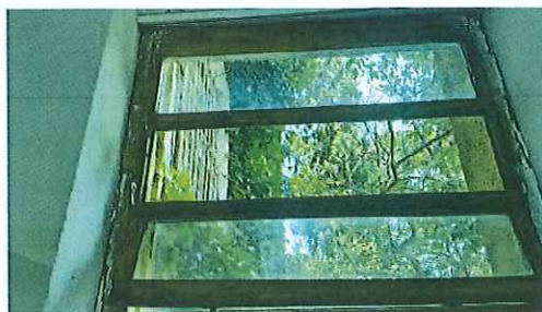
Foto te dritares ekistuese tek shkallet
