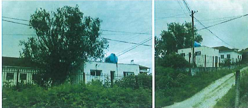
Foto te gjendjes ekzistuese te tualeteve
