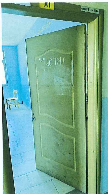
Foto te gjendjes ekzistuese te dyerve
