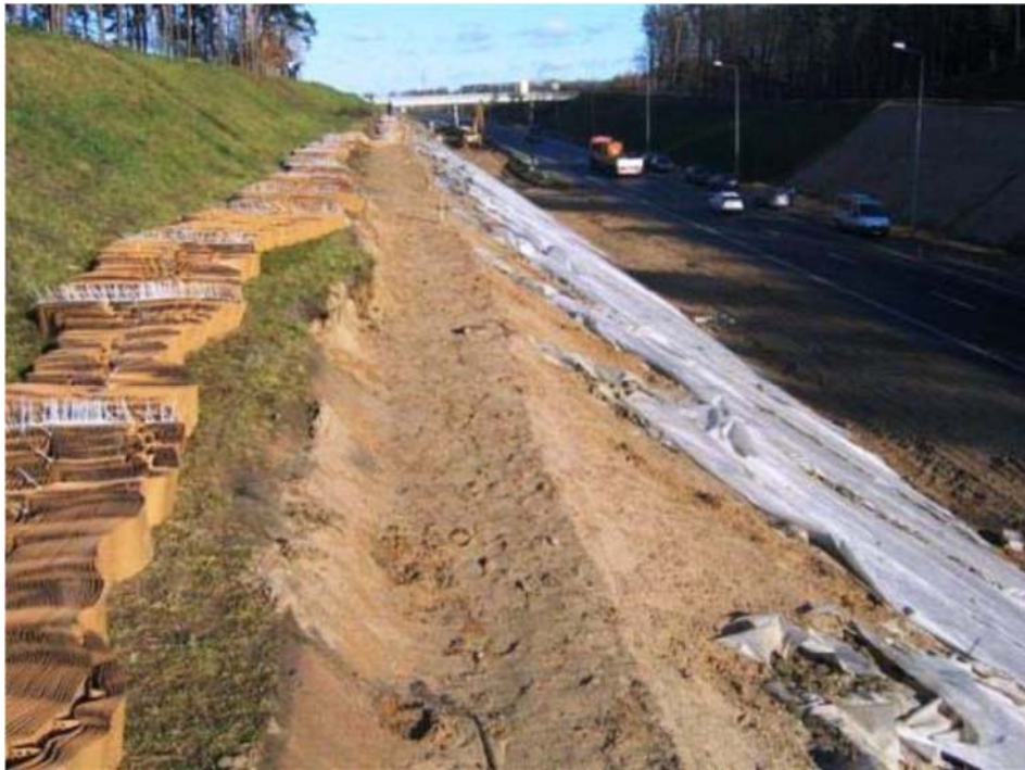
Figura 16- Pregatitja e ankorimit te Geocell
