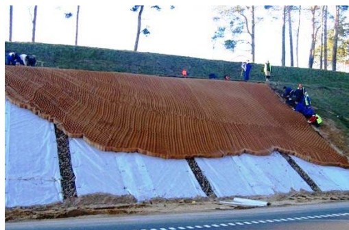
FIGURE 24. KANALET E KULLIMIT NE KRESHTE
