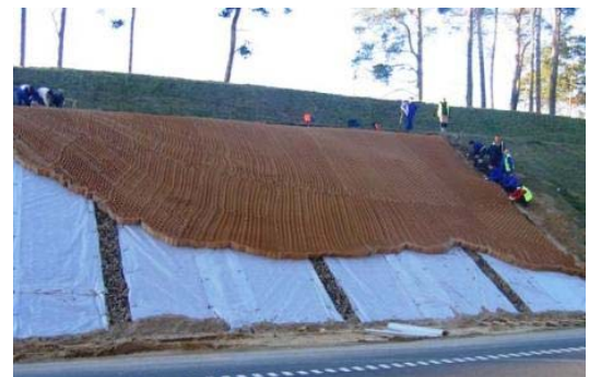
FIGURE 17. HAPJA E SEKSIONEVE NE SKARPATË
