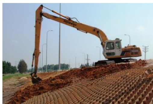
FIGURE 18. MBUSHJA ME DHE ME ESKAVATOR
