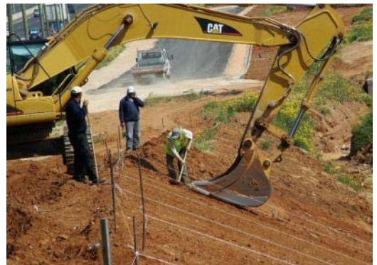
FIGURE 4. PASTRIMI DHE NIVELIMI I SKARPATËS
