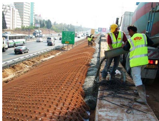
FIGURE 20. MBUSHJA ME BETON E KRESHTËS
