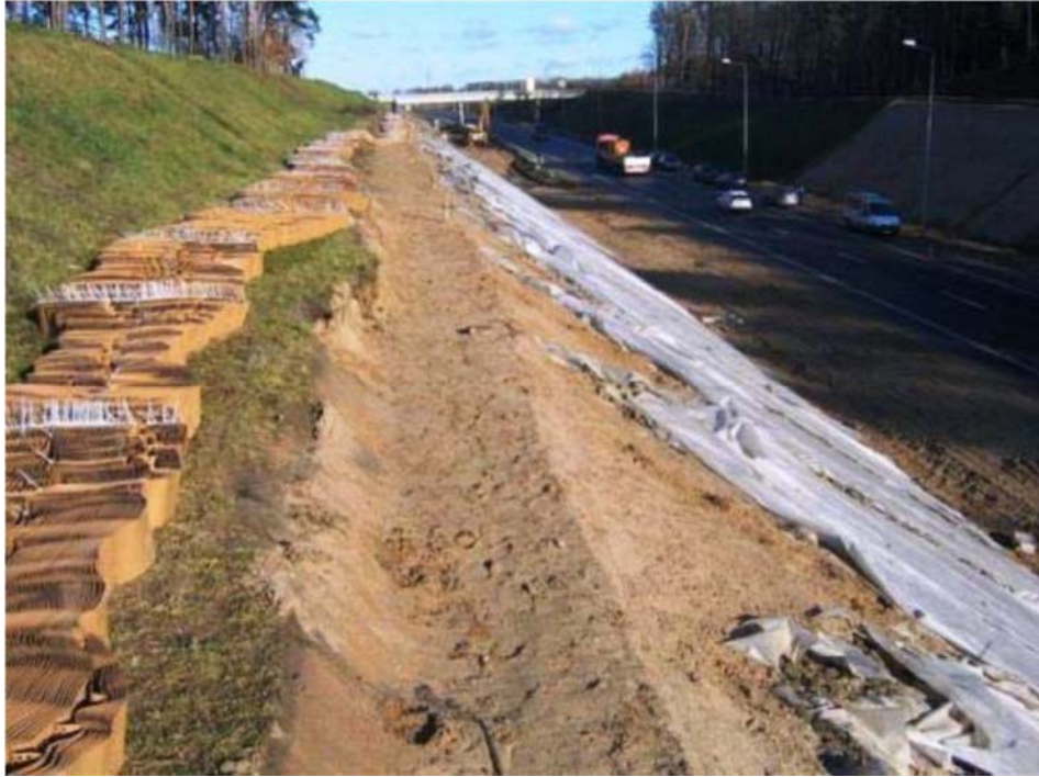
Figura 26- Pregatitja e ankorimit te Geocell
