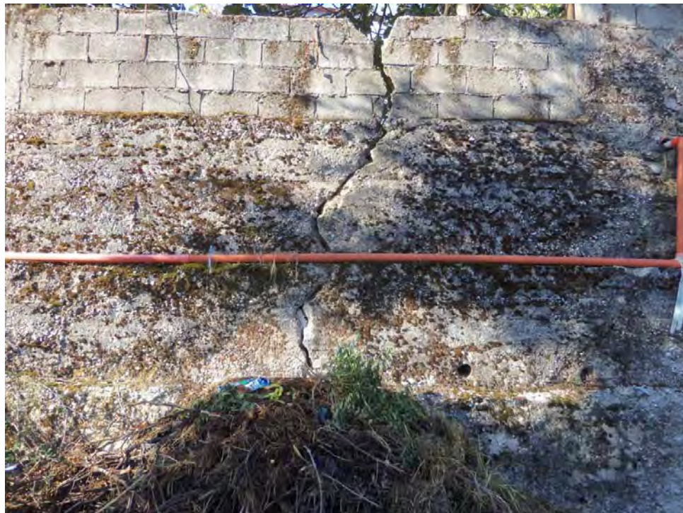
Figura 14– Çarje vertikale te Mureve
