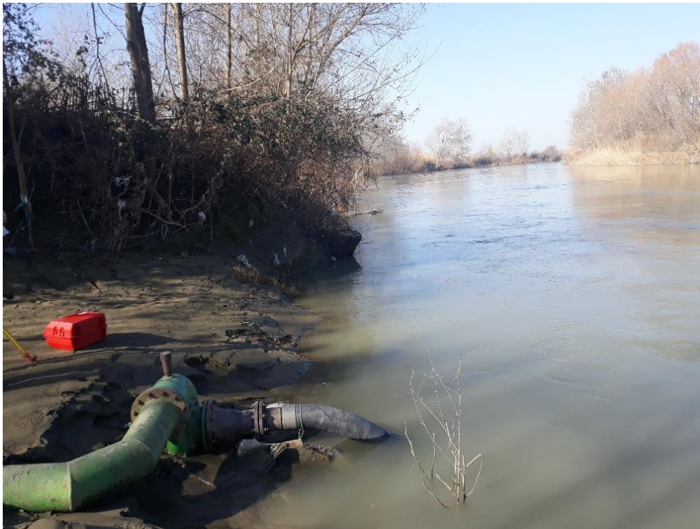
Tubacioni I thithjes se Pompes Egzistuese..
