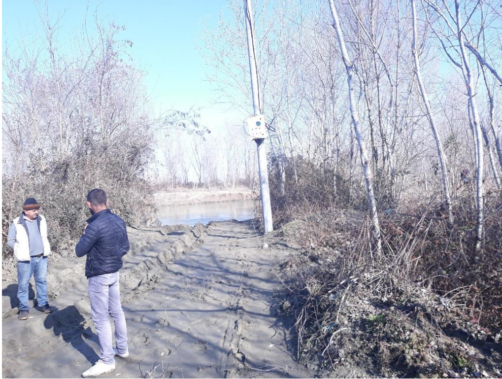
Pamje nga rruga per te sheshi ku do ndertohet Stacioni I Pompimit.
