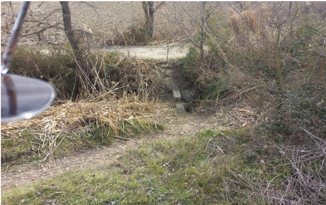
Pamje nga Kanali I Belines dega e djathte.
