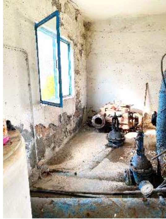
Gjendja e amortizuar e sistemit te komandimit te pompave
