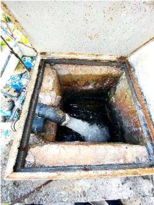
Puseta e kontrollit te depos se ujit dhe tubi I furnizimit nga puset
