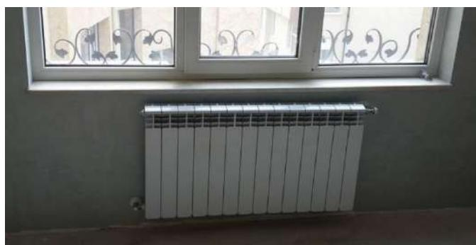
Radiatori duhet te kompletohet me mensolat per montimin ne mur to tij, si dhe tapat dhe reduksionet e nevojshme per montimin e valvolave dhe te detentoreve. Emetimit termik duke konsideruar  $\Delta T$  60°C sipas normes europiane UNI EN 442: minimumi 183 W (h=800 ) dhe 145 W (h=600 ) per  $\Delta T_{\text{ek}}$ , te barabarte me 50 °C.
