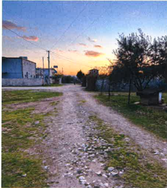
Foto te gjendjes ekzistuese Rruga Pashko Vasa
