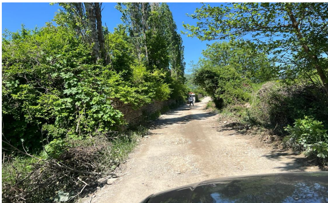
Figura 6: Gjendja ekzistuese e rrugës
