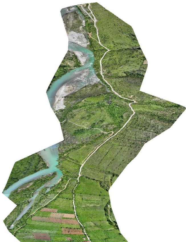
Figura 1: Imazh ne ortofoto i rruges
