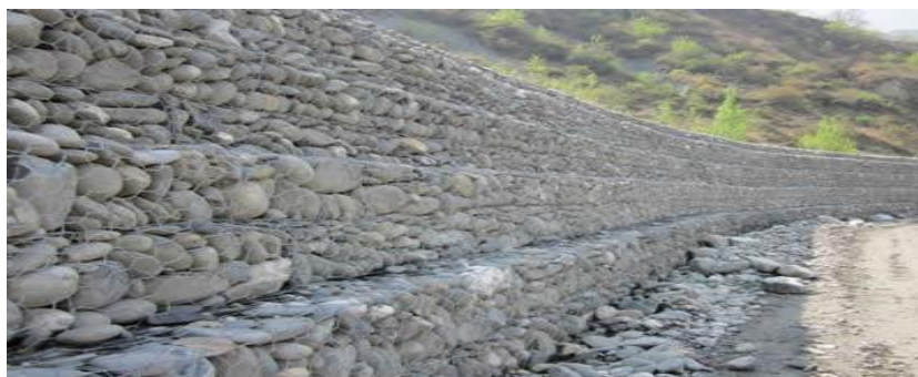
Foto ilustruese, Shembull sistemimi skarpate me mure gabiona
