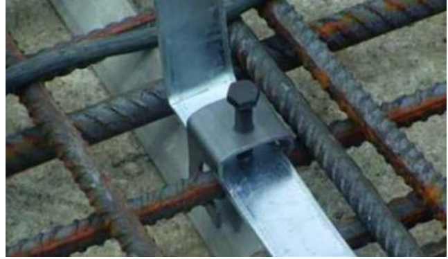
Figura 5. Detaj i fiksimit të shiritit të tokëzimit në zgarën e hekurit
