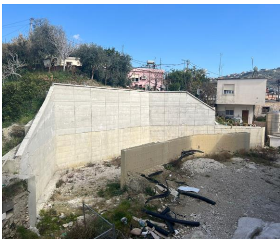
Gjendja ekzistuese e trupit të rrugës
