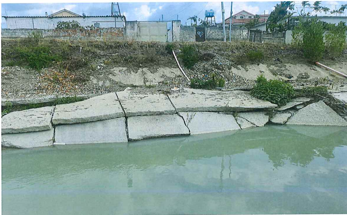
Foto 4. Pamje e çarjeve të veshjes të bazes dhe skarpatave anesore perroit të Zaranikës
