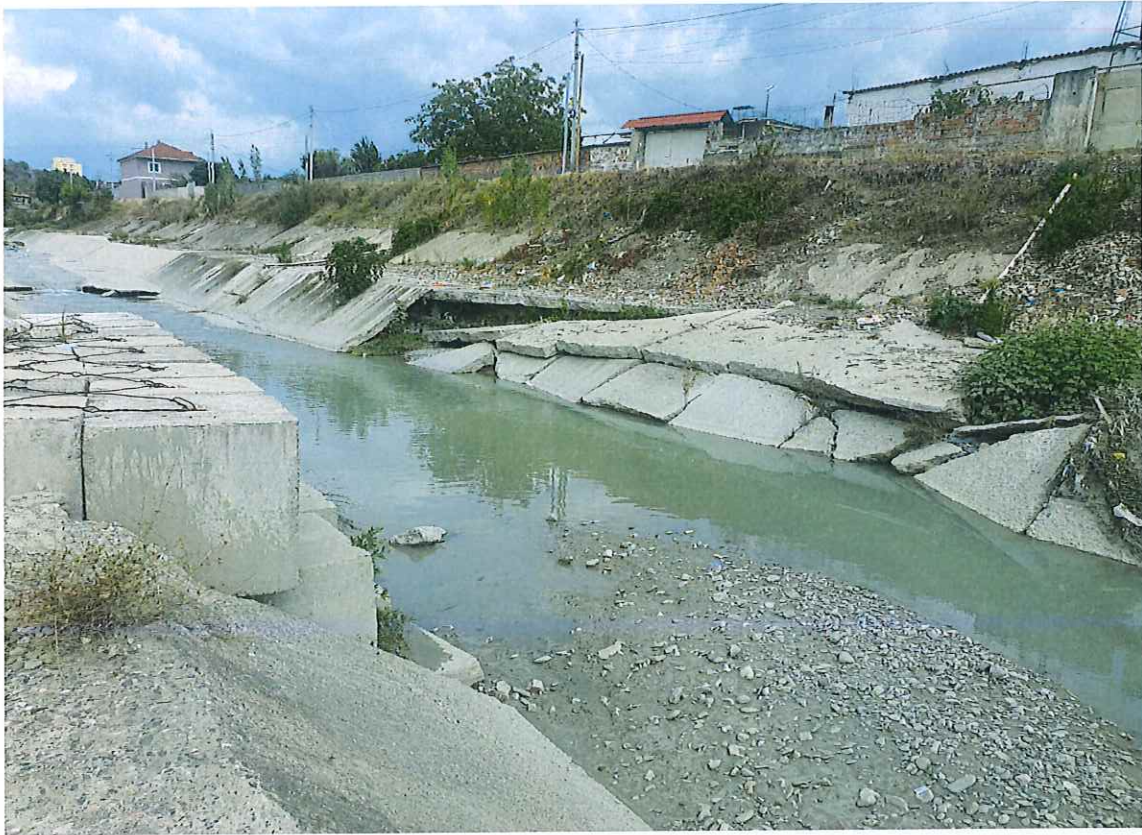
Foto 8. Pamje e prishjeve te bazes dhe skarpatave te shtratit të Zaranikës
