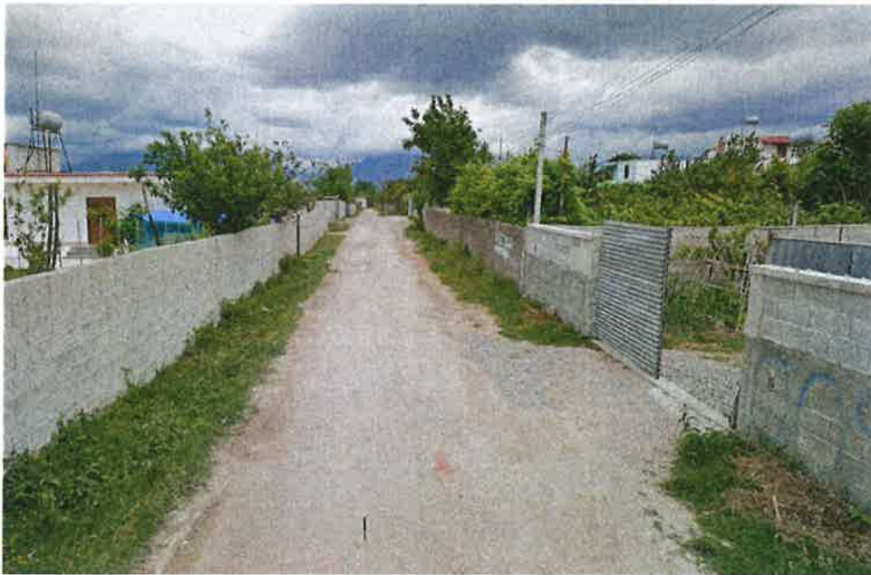
Foto te gjendjes ekzistuese
