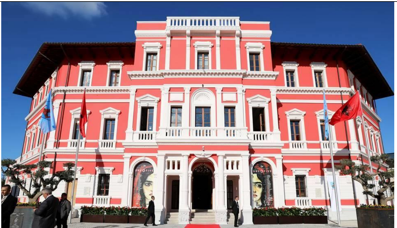
Fasada kryesore e objektit, mars 2018.
