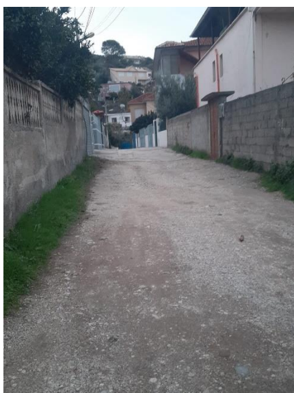
Gjendja ekzistuese e trupit të rrugës
