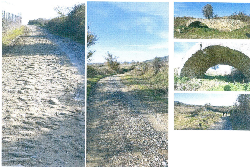
Fig.3: Foto të gjendjes ekzistuese të rrugës
