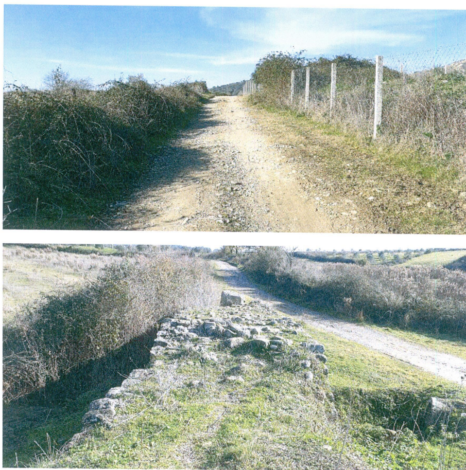
Fig.2: Foto të gjendjes ekzistuese të rrugës
