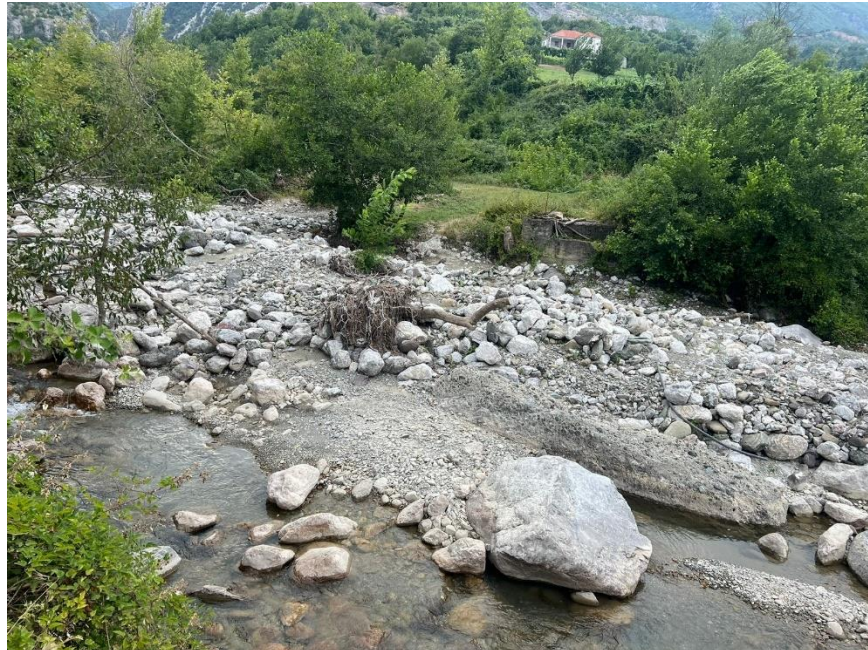
Figura 5: Gjendja ekzistuese e ures
