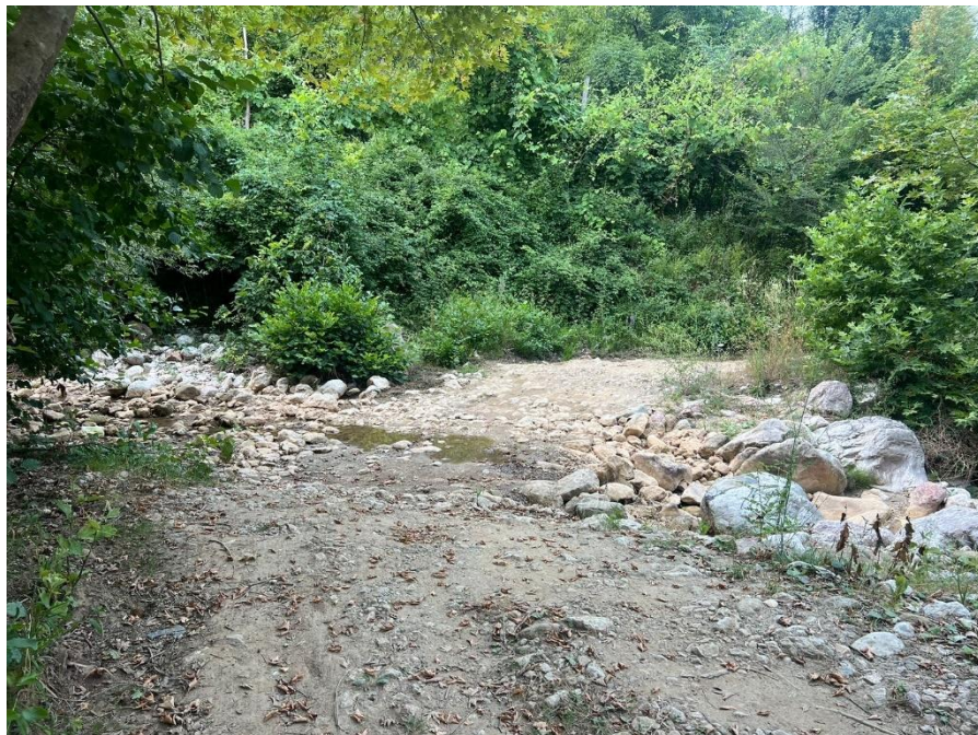
Figura 3: Gjendja ekzistuese e urës
