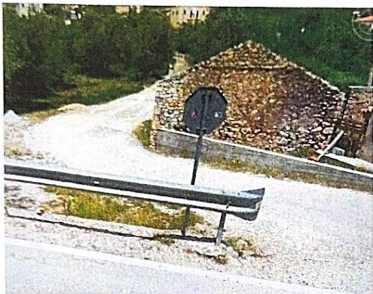
Foto të gjendjes ekzistuese
