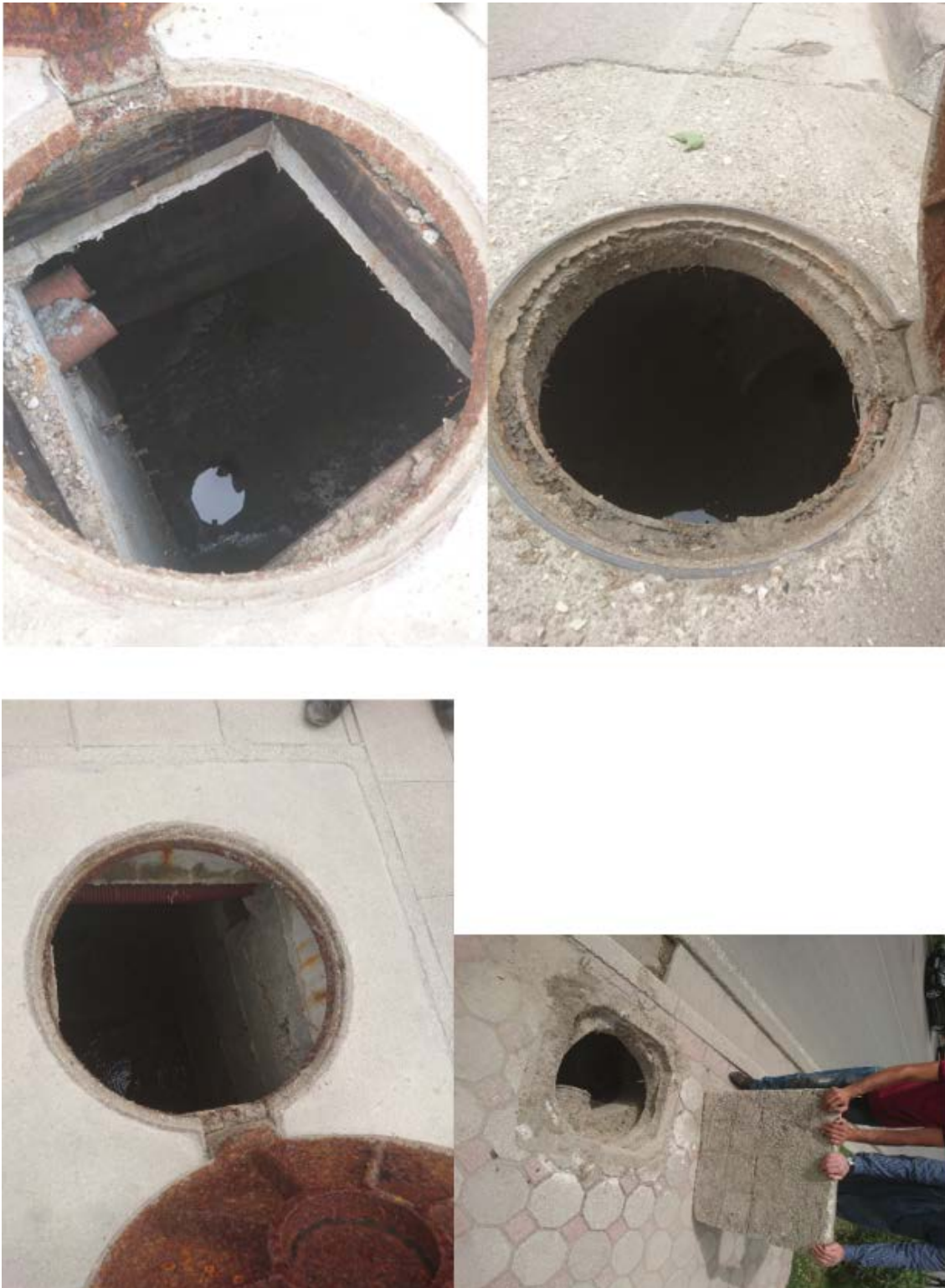
Figure 2-4 Pamje te pusetave ne zonat e rehabilituara te trotuareve
