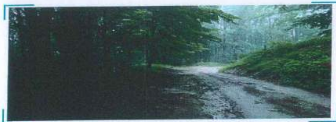
Fotografia 5: Reshjet e mëdha, përdorimi jo i duhur dhe mirëmbajtja e pamjaftueshme/jo e duhur e shkaktojnë erozionin e madh të rrugës për bartje të një rruge pyjore (Fotografia: Juri Begu)
