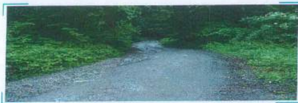
Fotografia 14: Degët e sërvarura duhet të hiqen për të mundësuar që drita e diellit dhe era të depërtojnë në sipërfaqen rrugore në mënyrë që të mundësojnë tharjen e saj.
