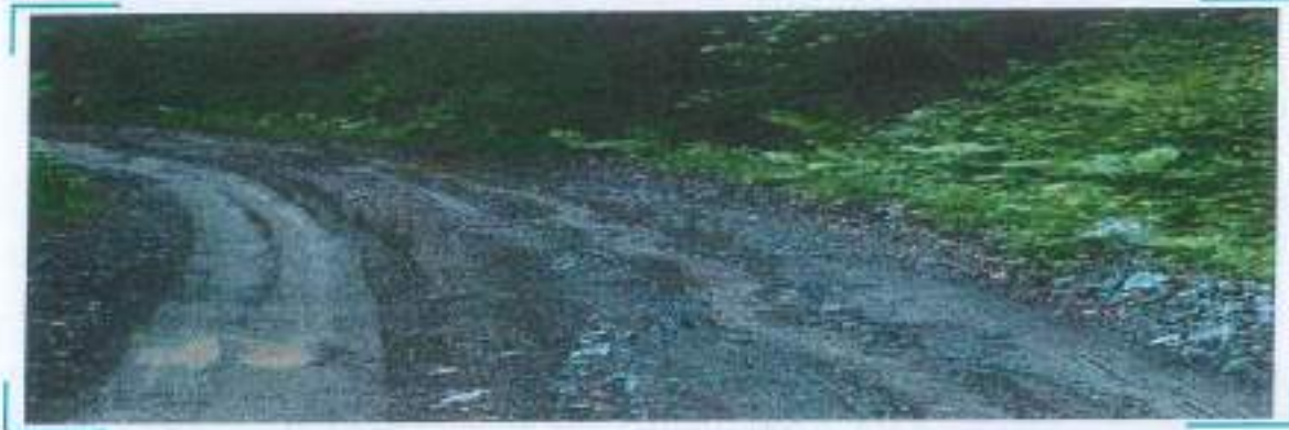
Fotografia 13 : Vraga e rrotave në rrugë si rezultat i kamionëve të shtingarkuar që lëvizin në rrugë me sistem jo të duhur drenazhimi dhe me kapacitet bartës të pamjaftueshëm të shtresës
