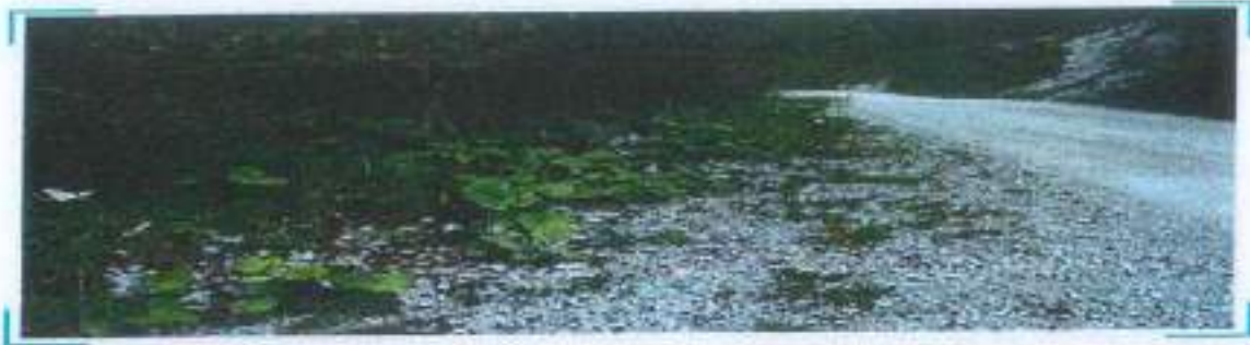
Fotografia 8: Shmangni krijimin e një strati me material anash rrugës për burtje (Fotografia: Juri Begu)
