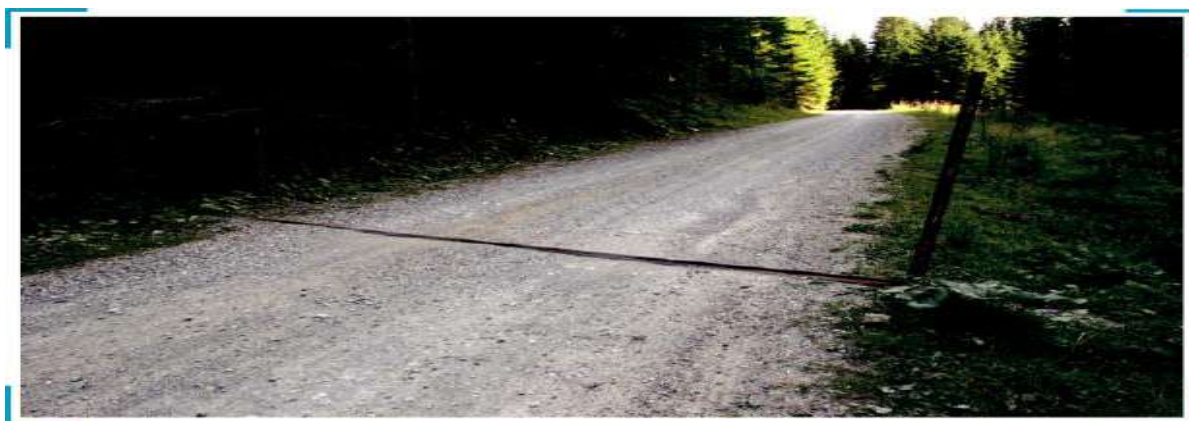
Fotografia 11: Kanali i tërthortë (Fotografia: Juri Beguš)
