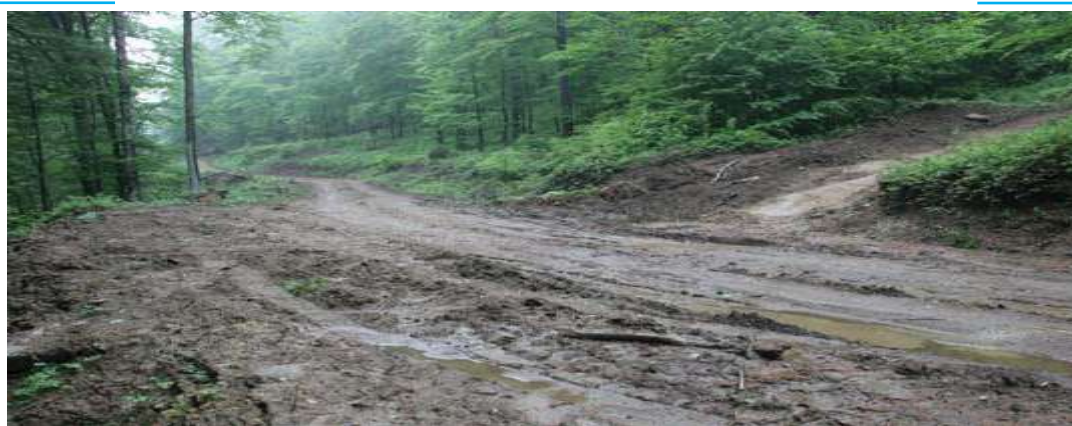
Fotografia 16 : Hapi i fundit i mirëmbajtjes së rrugës është kompaktësimi/ngjeshja. Kjo e rrit jetëgjatësinë e rrugëve pyjore
