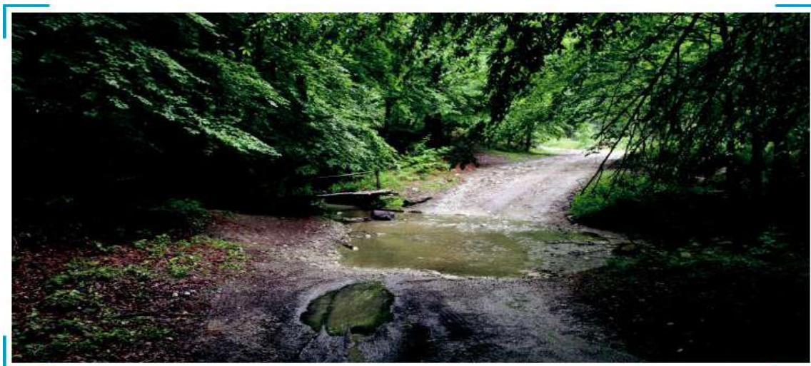
Fotografia 3: Një lug i bërë prej betoni ose guri duhet të parashihet në fazën e planifikimit për kalimene një përroi sikurse ky që është paraqitur më sipër (Fotografia: Juri Beguš)
