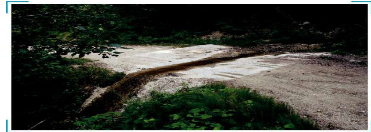
Fotografia 8: Shmangni krijimin e një shtrati me material anash rrugës për bartje (Fotografia: Juri Beguš)
