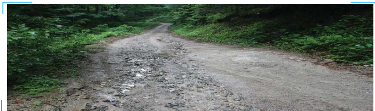
Fotografia 12 : Zgjidhjet për problemin në këtë fotografi janë: largimi i vegjetacionit, ndërtimi i një kanali anësor, mbushja e rrugës me zhavorr, rrafshimi dhe formësimi i profilit të kurorës, ngjeshja/presim
