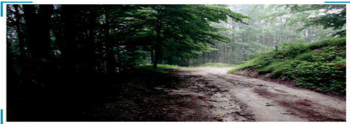
Fotografia 5: Reshjet e mëdha, përdorimi jo i duhur dhe mirëmbajtja e pamjaftueshme/jo e duhur e shkaktojnë erozionin e madh të rrugës për bartje të një rruge pyjore (Fotografia: Juri Beguš)
