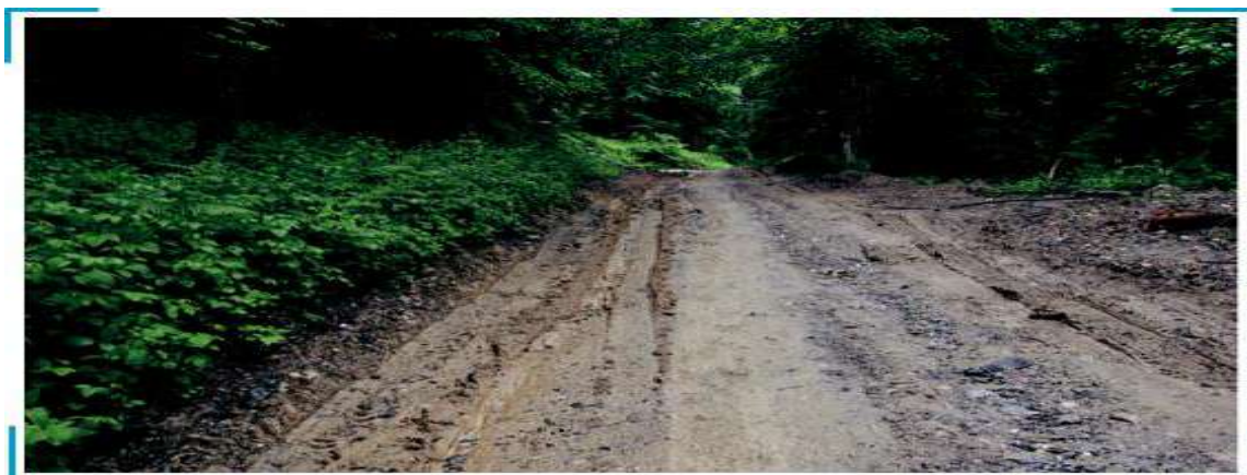
Fotografia 6: Një lug ujëmbledhës prej betoni mundëson kalimin e përroit përmbi rrugë (Fotografia: Juri Beguš)
