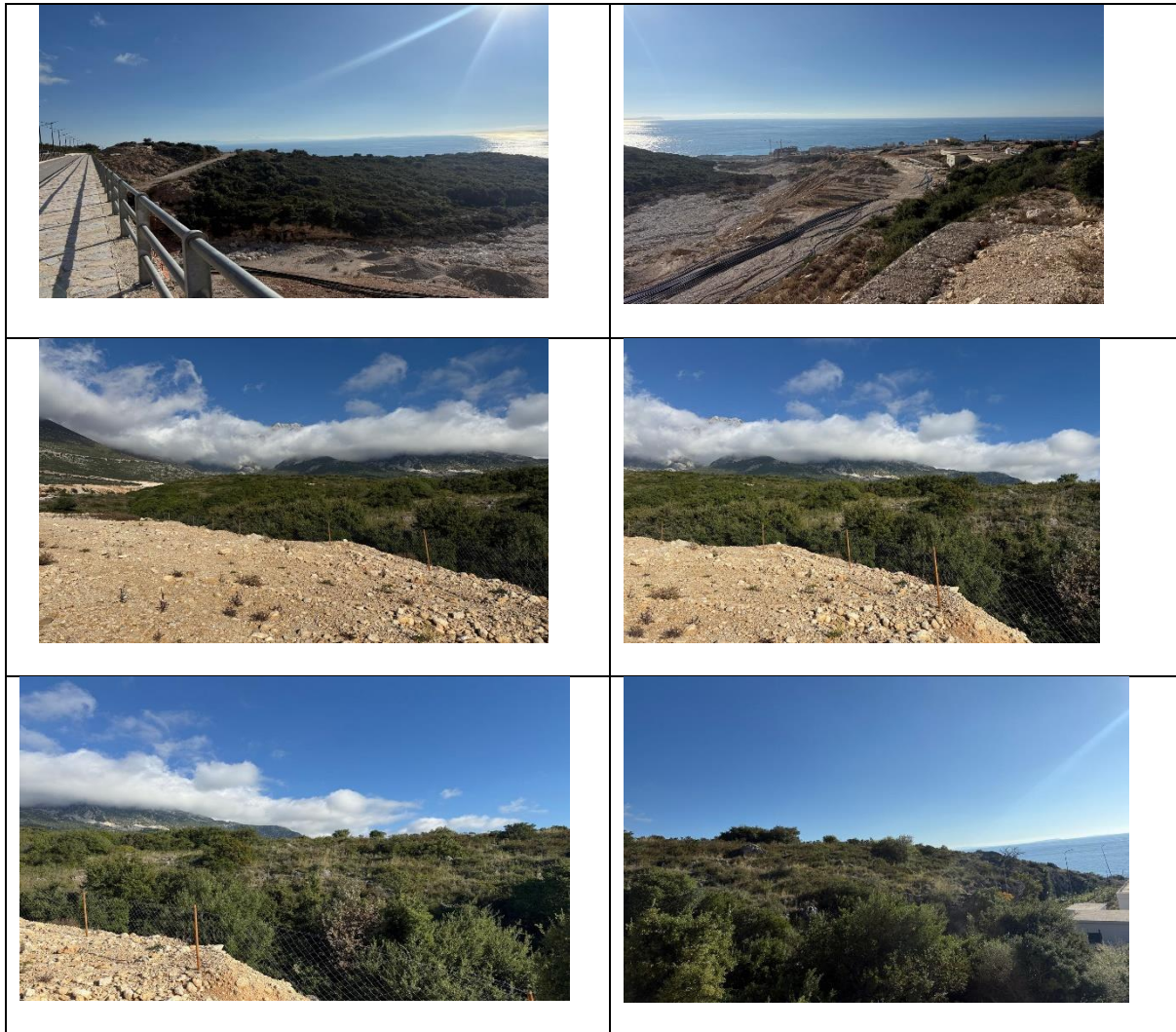
Figura 2: Foto-Gjendja ekzistuese e segmentit rrugor
