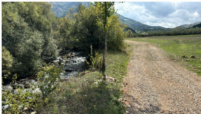
Figura 8: Gjendja ekzistuese e rrugës
