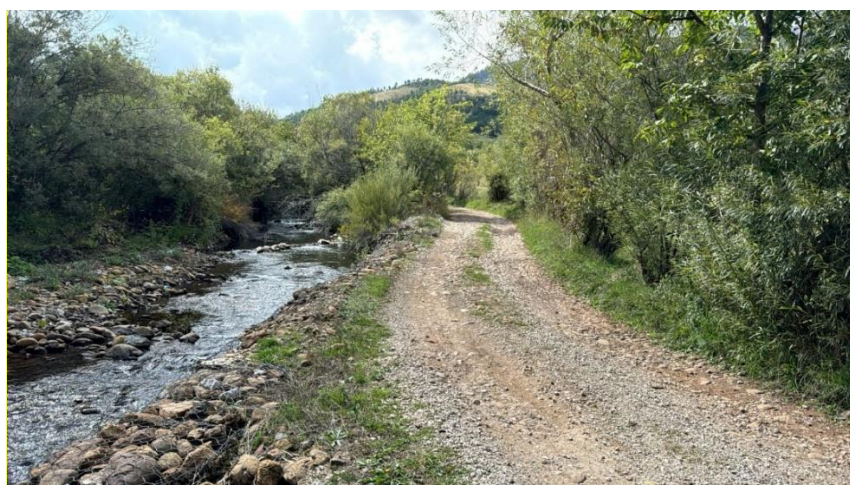
Figura 6: Gjendja ekzistuese e rrugës
