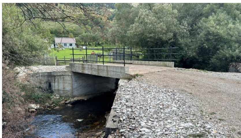
Figura 9: Gjendja ekzistuese e rrugës
