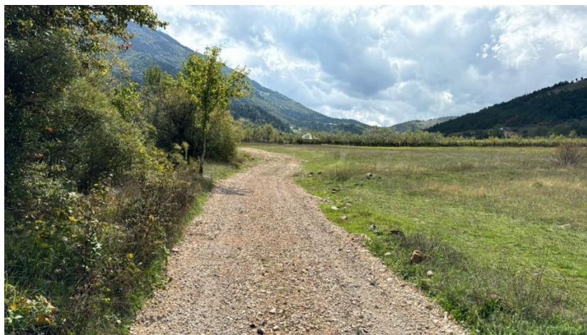
Figura 7: Gjendja ekzistuese e rrugës
