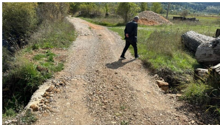
Figura 3: Gjendja ekzistuese e rrugës
