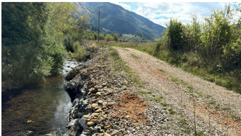
Figura 4: Gjendja ekzistuese e rrugës
