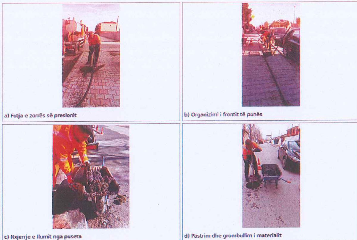
Figura 3. Organizimi i frontit të punës, futja e zorrës së presionit, nxjerrja e llumit dhe grumbullimi i kontrolluar.
