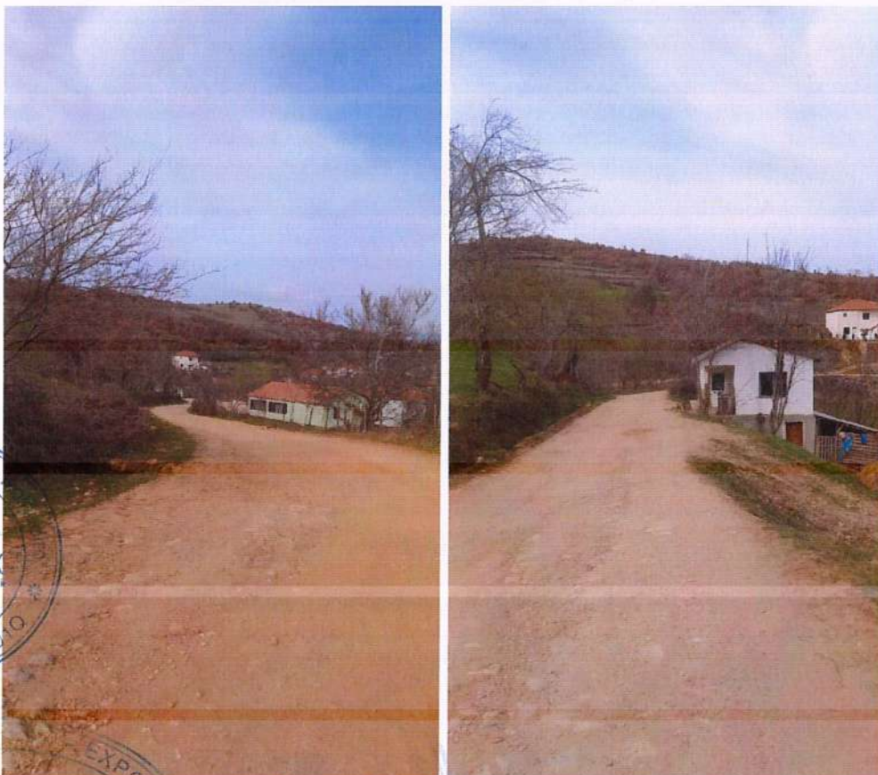
Figura 24 Gjendja ekzistuese e rruges
