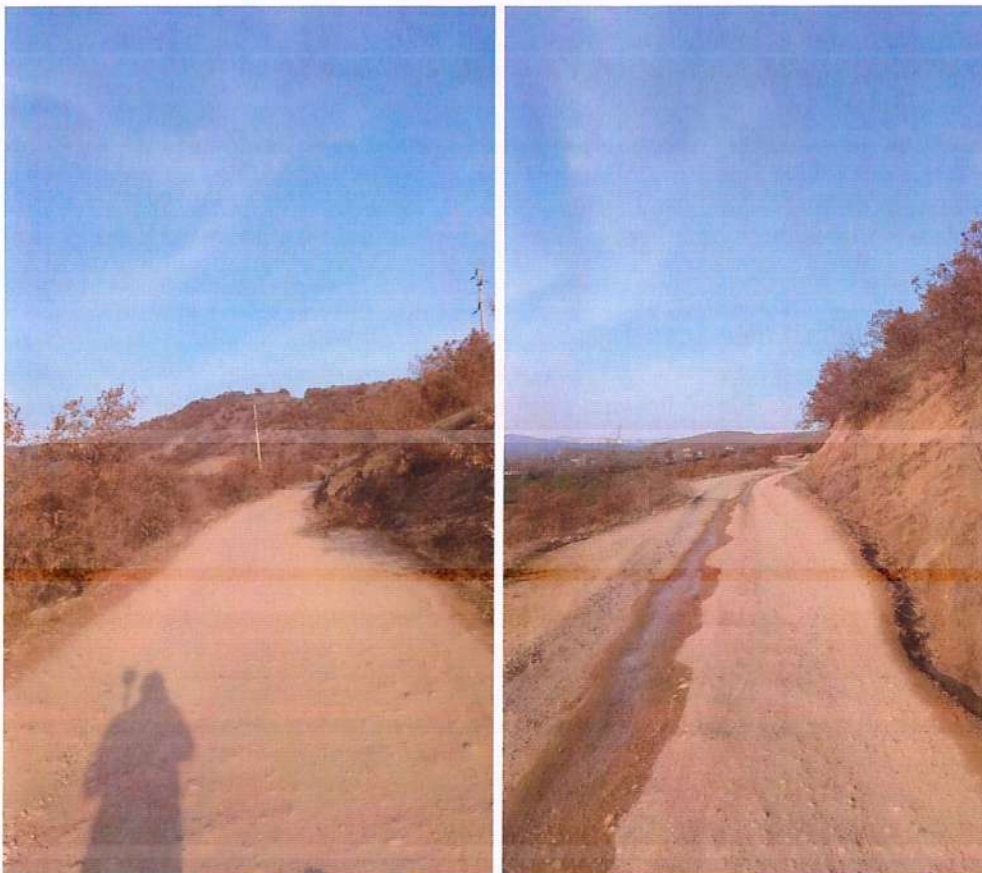
Figura 3 Gjendja ekzistuese e rruges
