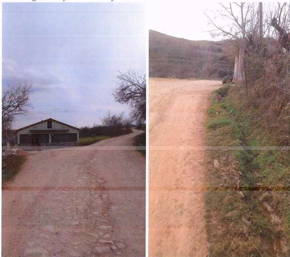
Figura 25 Gjendja ekzistuese e rruges
