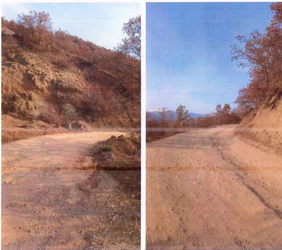
Figura 5 Gjendja ekzistuese e rruges
