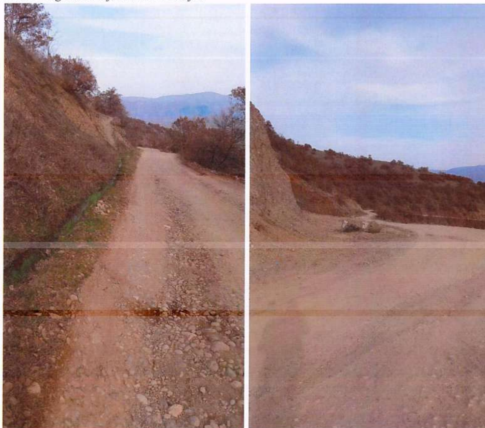
Figura 33 Gjendja ekzistuese e rruges
