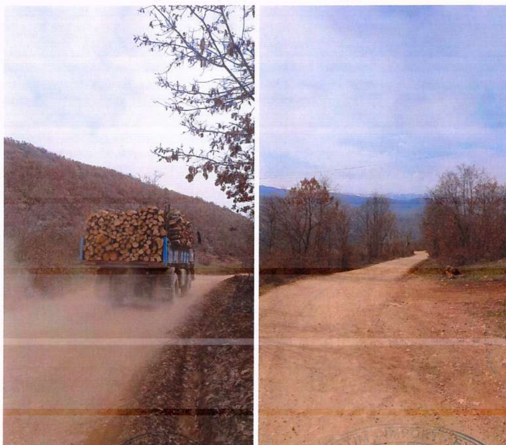
Figura 14 Gjendja ekzistuese e rruges
