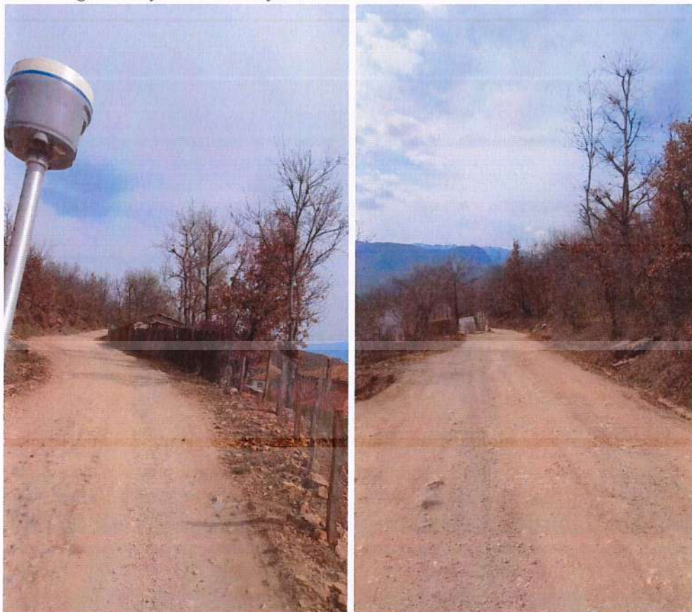
Figura 15 Gjendja ekzistuese e rruges
