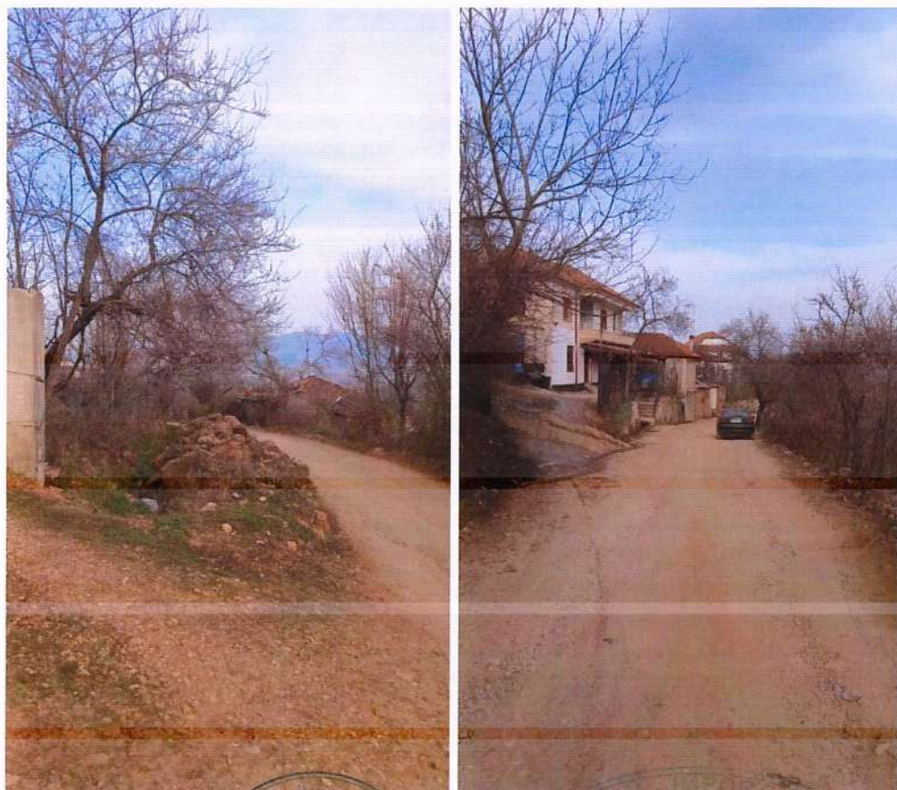
Figura 26 Gjendja ekzistuese e rruges
