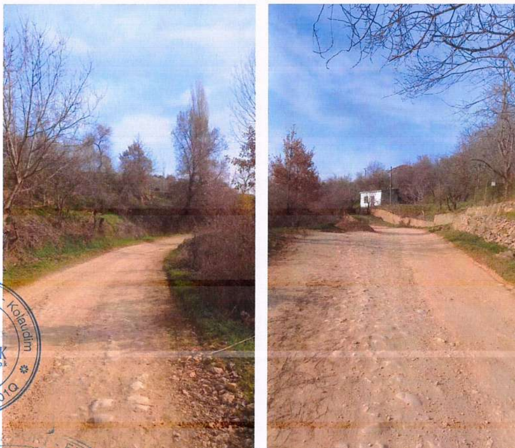
Figura 8 Gjendja ekzistuese e rruges
