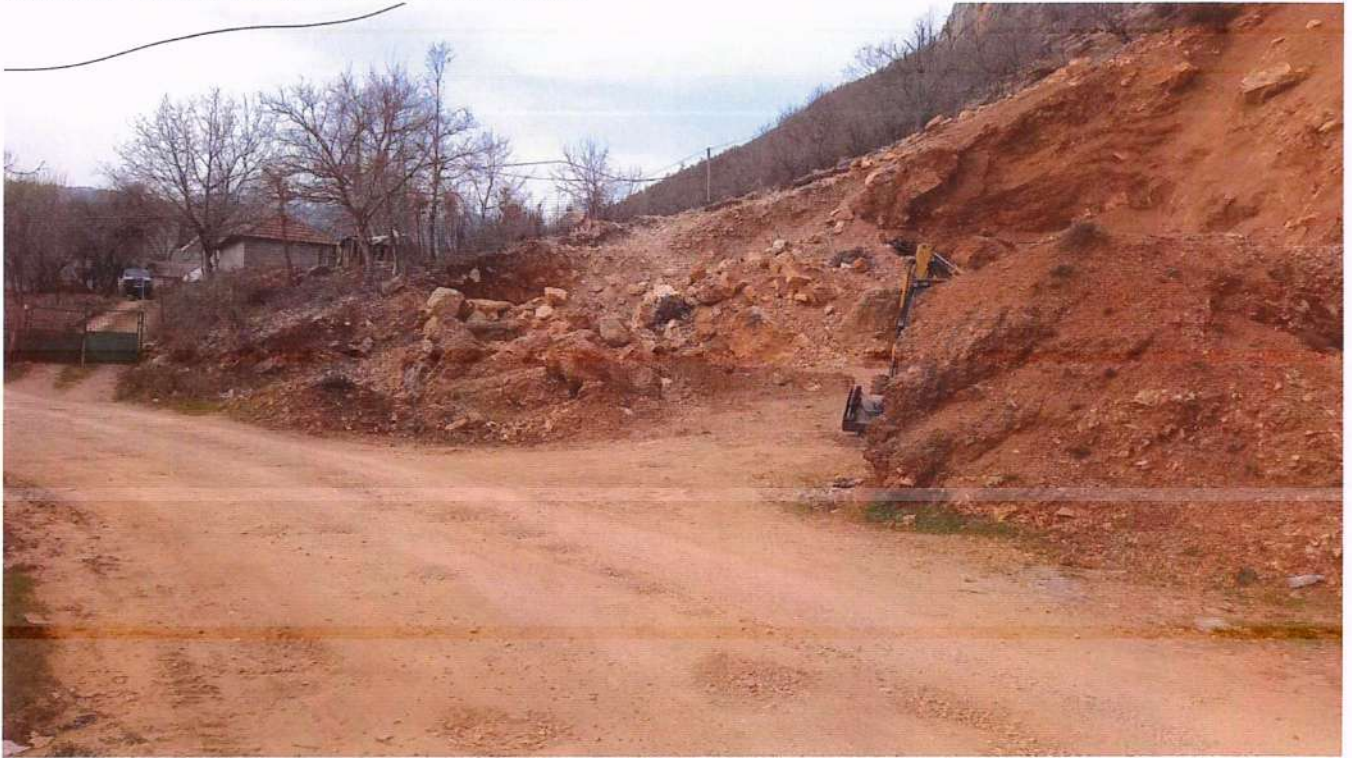
Figura 21 Gjendja ekzistuese e rruges
